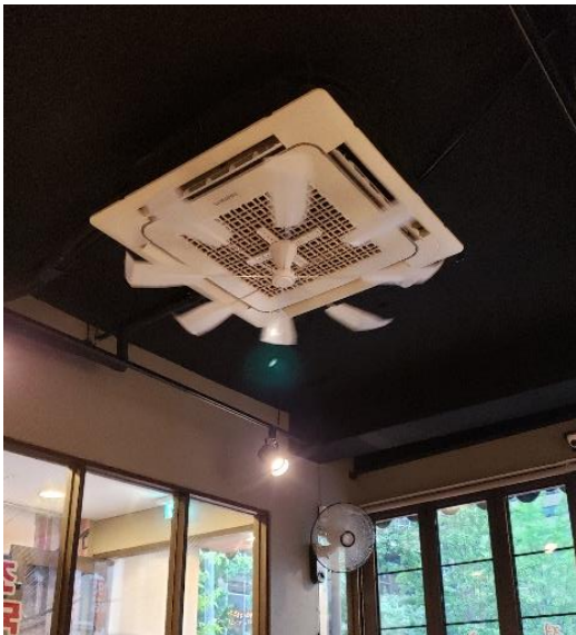
(바람개비 같은 팬을 부착하였다. 에어컨에서 나오는 바람으로 팬이 빙빙 돌아가고 있다. 팬이 돌면서 냉기를 분산을 시키고 있다.)
