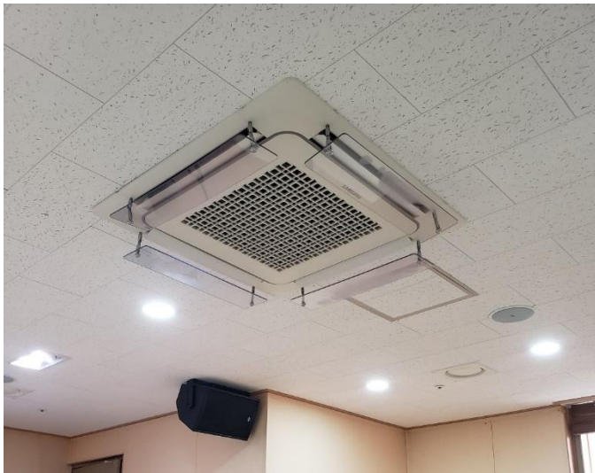
(에어컨에서 찬 바람이 나오는 입구에 덮개판을 부착하여 찬 바람을 널리 퍼트리고 있다.)
